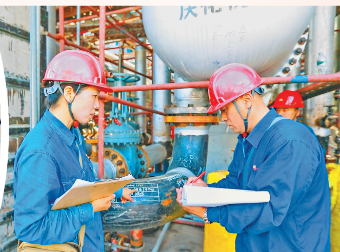
大庆石化大炼油项目现场。本版图片均由本报记者 郭俊峰摄
