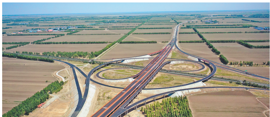
绥大高速小城市枢纽互通式立体式交叉。
