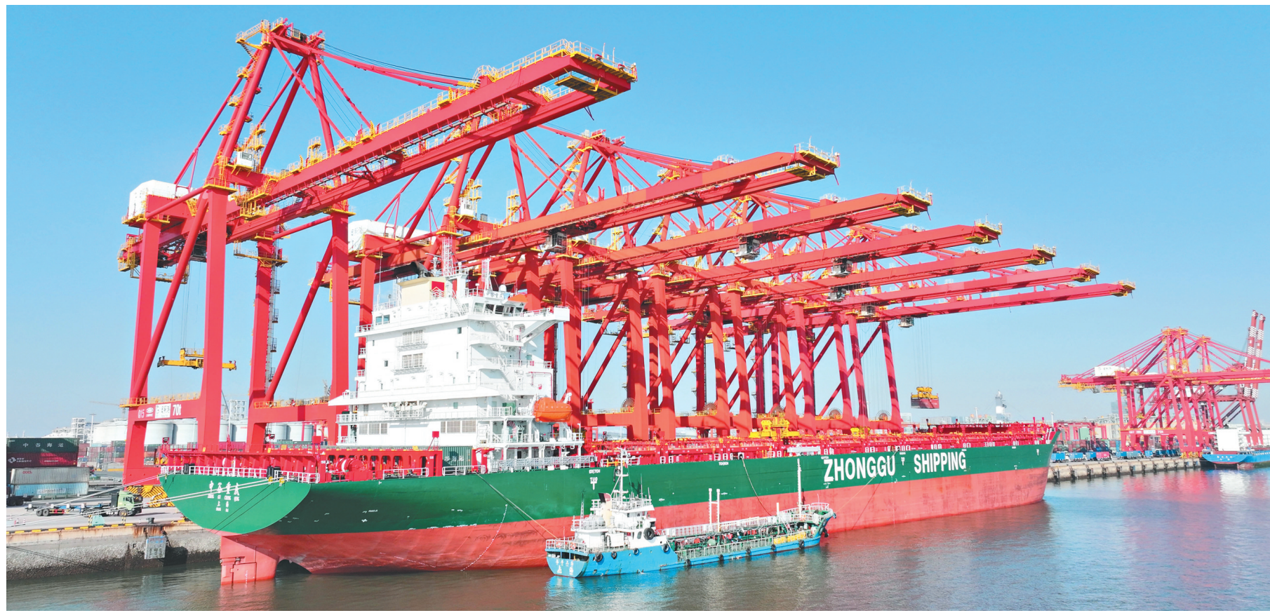
在山东港口日照港,货轮停泊集装箱码头装卸作业。
