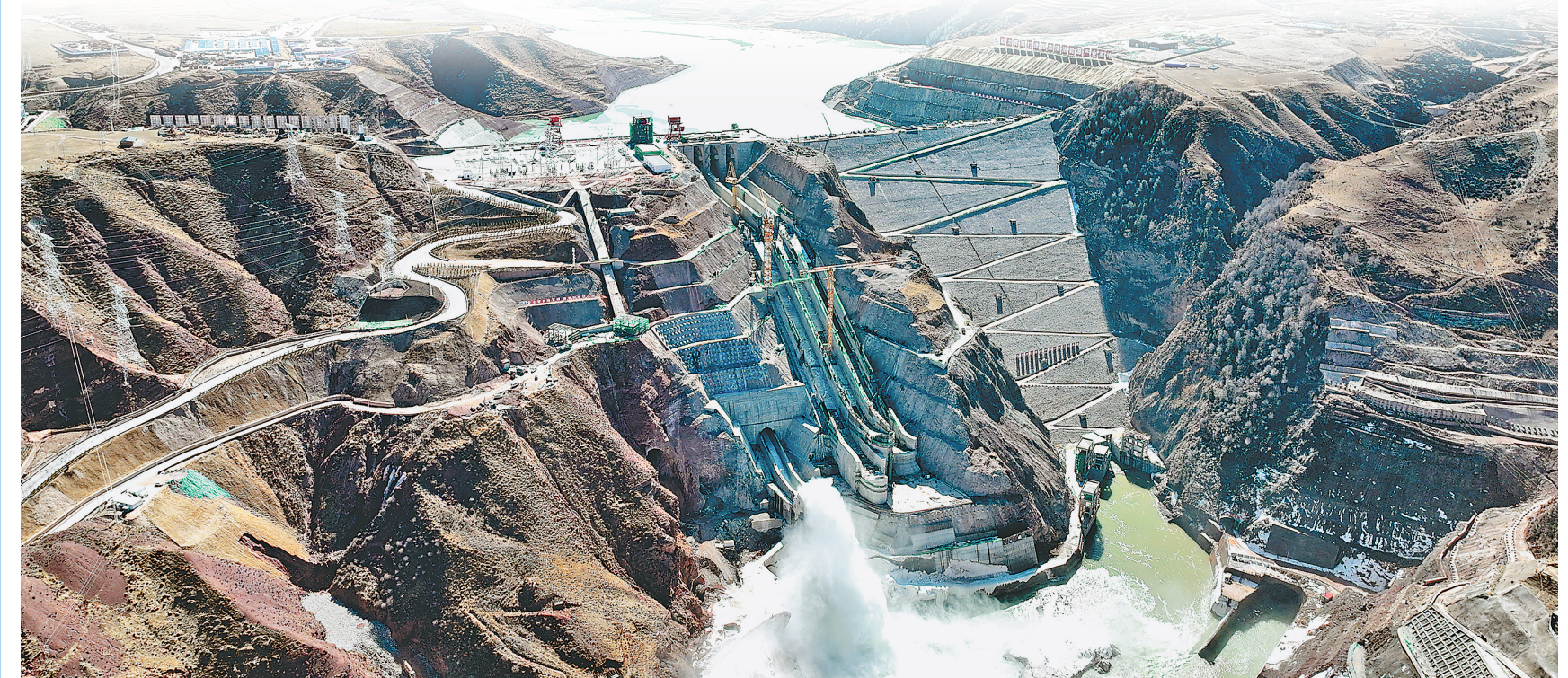
玛尔挡水电站首台5号机组正式并网发电。 新华社记者 张龙摄
