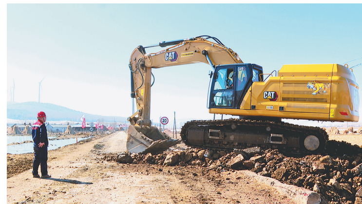
公路项目建设现场,挖掘机进行便道施工。 本报记者 潘宏宇摄
