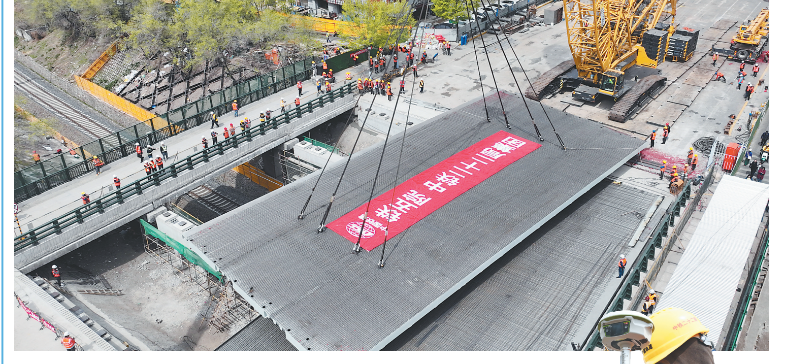
上图:履带起重机将钢箱梁吊到设计线位。下图:工作人员手持GPS精准定位。 本报记者 郭俊峰摄
