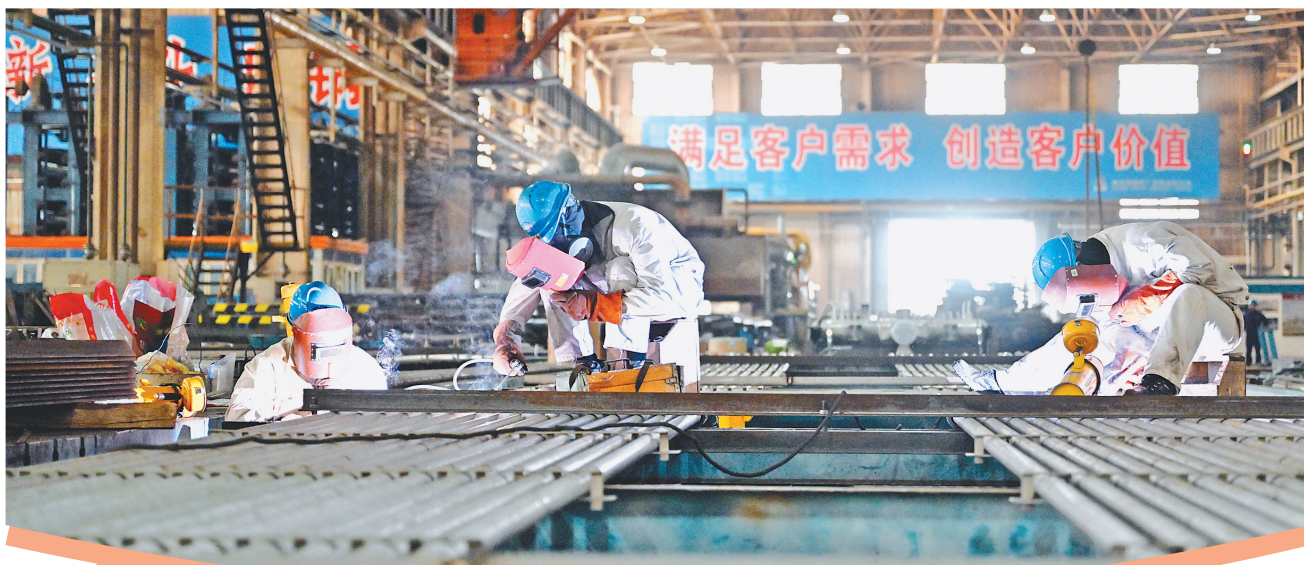
焊工焊接管排。
