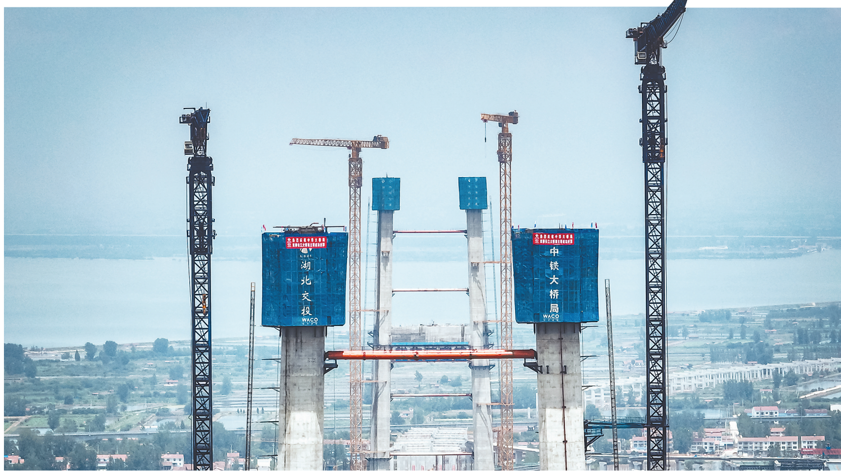
5月24日,由中铁大桥局集团负责施工的新港高速公路双柳长江大桥南主塔完成封顶。新港高速公路双柳长江大桥及接线工程连接武汉新洲区 and 鄂州华容区,是武汉城市圈环线的重要组成部分,大桥采用双向八车道建设标准,设计速度120公里/小时。这是在湖北省鄂州市拍摄的新港高速公路双柳长江大桥南主塔施工现场。新华社记者 伍志尊摄
