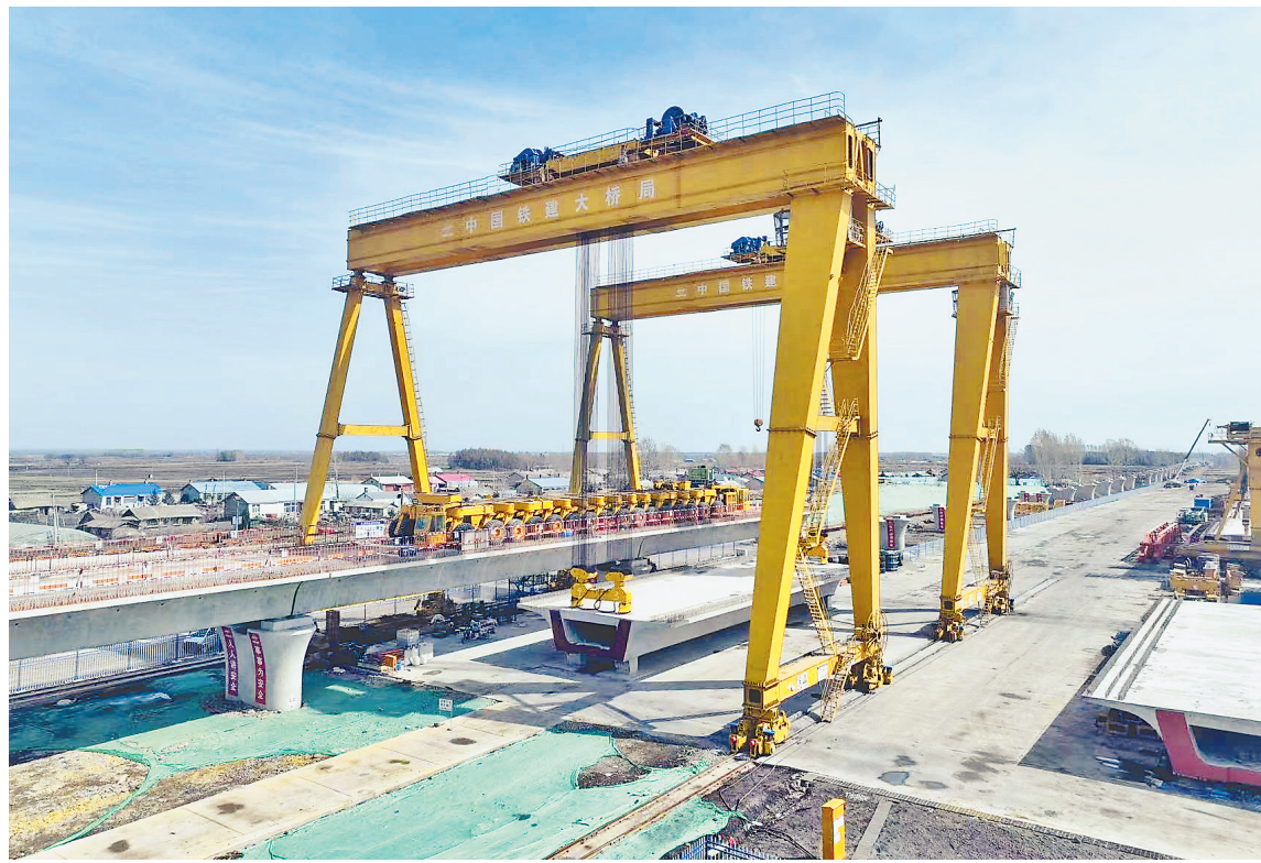
来自中国铁建大桥工程局集团的建设者在哈(尔滨)伊(春)高铁现场奋战。
