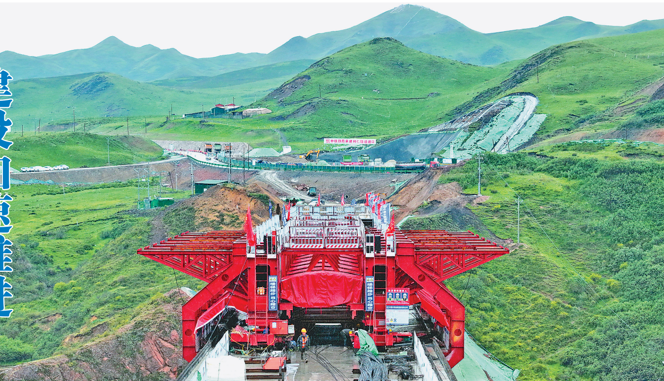
这是6月3日拍摄的建设中的西成铁路甘肃段白龙江大桥。
