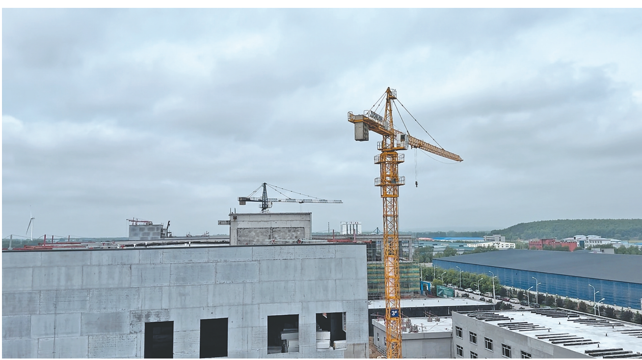
二期项目建设现场。
