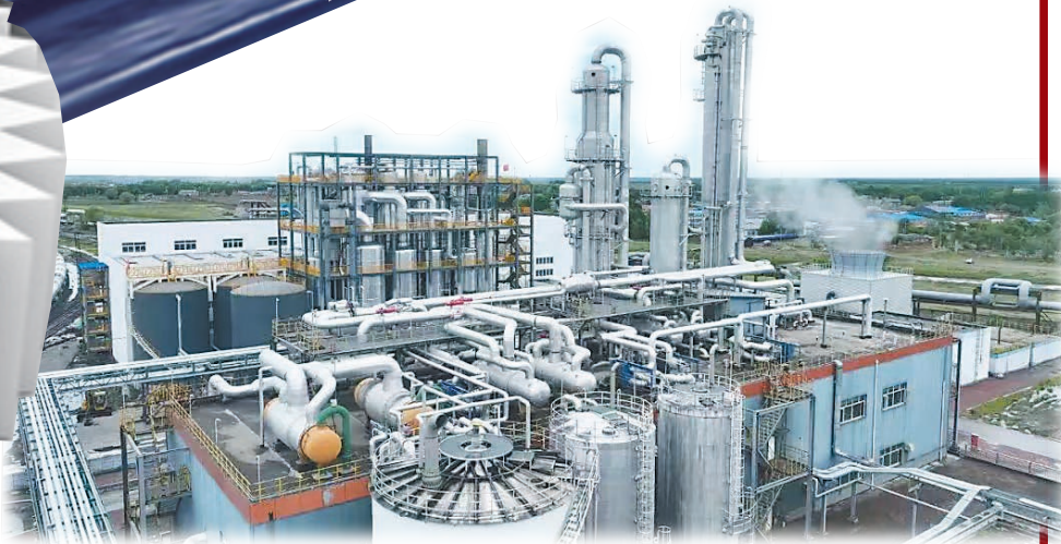
中粮生化厂区。于洋摄
