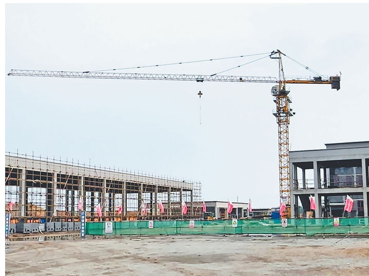
项目建设现场。
