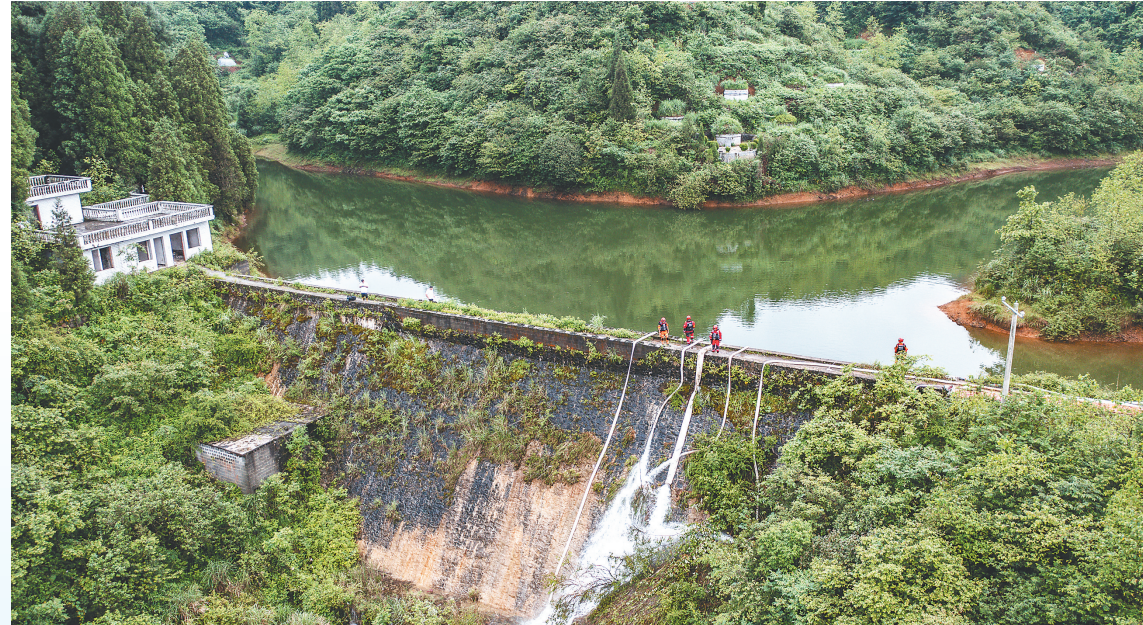
6月23日,贵州省毕节市消防救援支队的工作人员在清排织金县双堰街道桂花社区山塘积水。 新华社记者 陶亮摄
