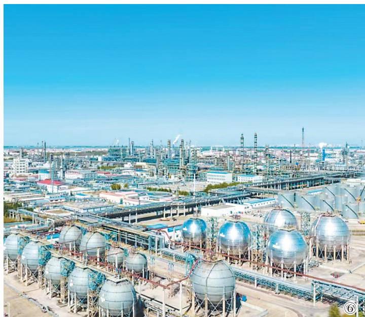
①大庆石化年40万吨芳烃抽提装置。 ②大庆石化在化肥运行部合成氨装置罐区现场,与市生态环境局共同举办2024年“地企联合”突发环境事件应急演练。 ③大庆石化一线员工通过调整阀门,确保装置平稳运行。 ④大庆石化公司催化重整装置区技术人员确认现场设备设施情况。 ⑤在大庆石化化工区中心控制室内,岗位员工正在精心监盘,调整运行参数。 ⑥大庆石化化工区全景。 本版图片均由大庆石化公司提供
