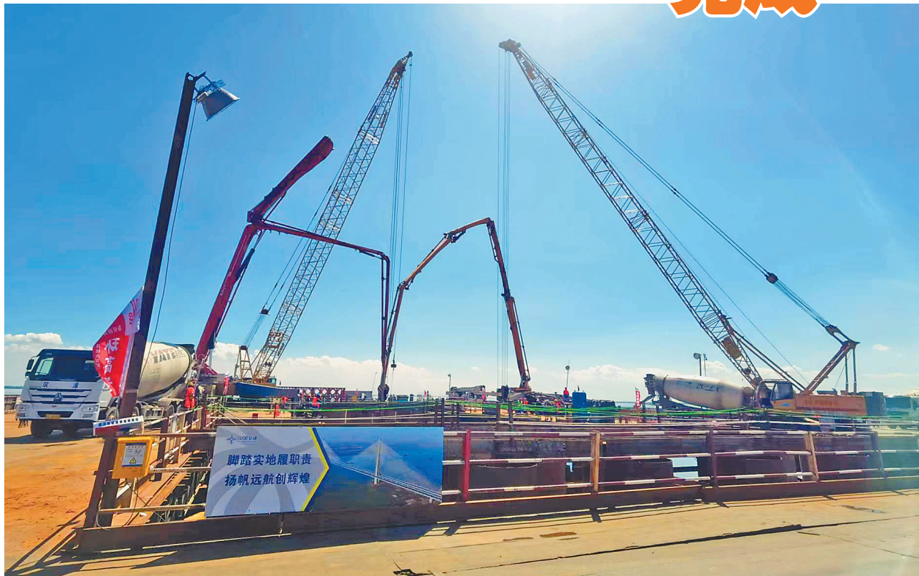
施工现场。图片由受访单位提供
