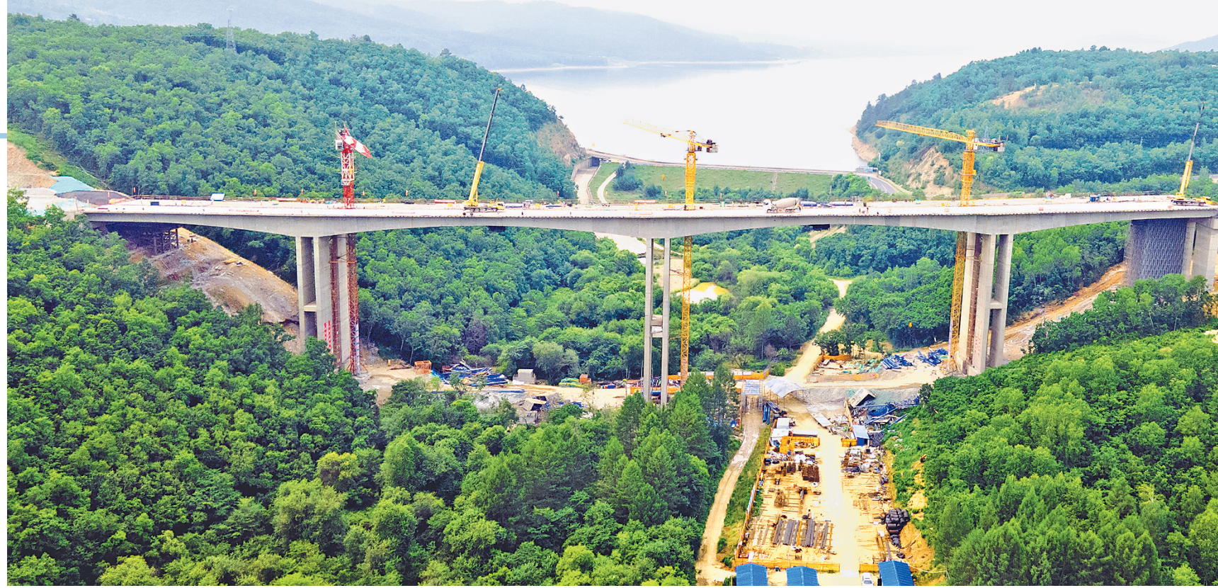
卧牛湖高架桥主桥合龙。
