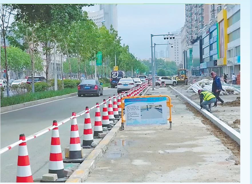
施工现场。本报记者 邢汉夫摄
