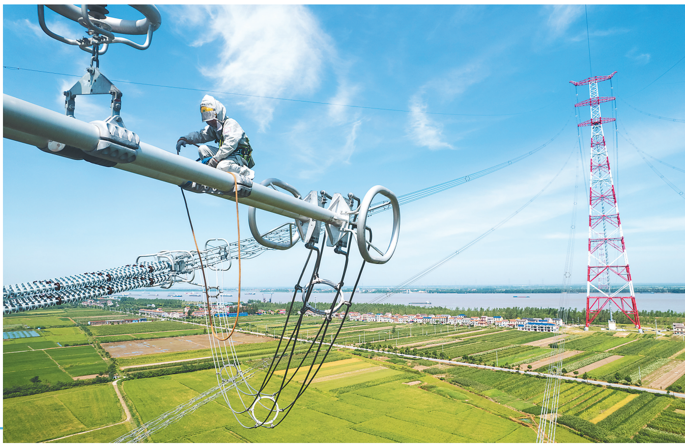
7月23日,在南荆长特高压工程荆门线,电力工人在对线路进行检修(无人机照片)。
