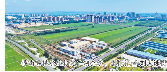
桦南县供水改扩建二期全景。本报记者刘大泳摄
