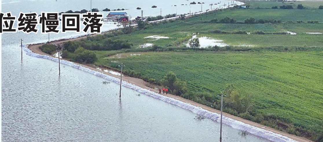
饶河镇大楞堤防。
