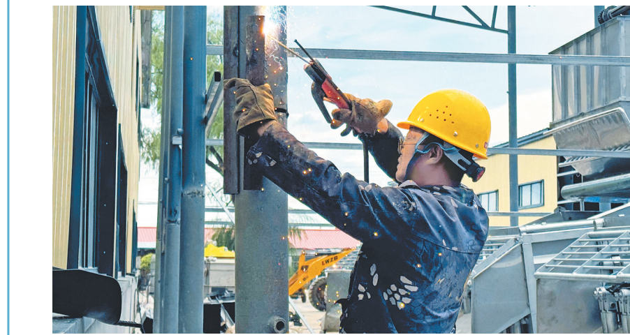
工人正在进行焊接作业。孔春苗摄
