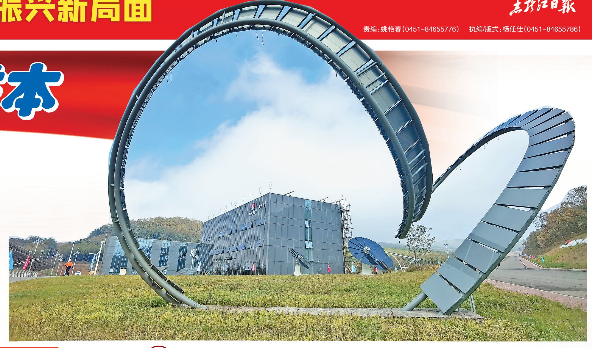
造型别致的光伏发电设施。
