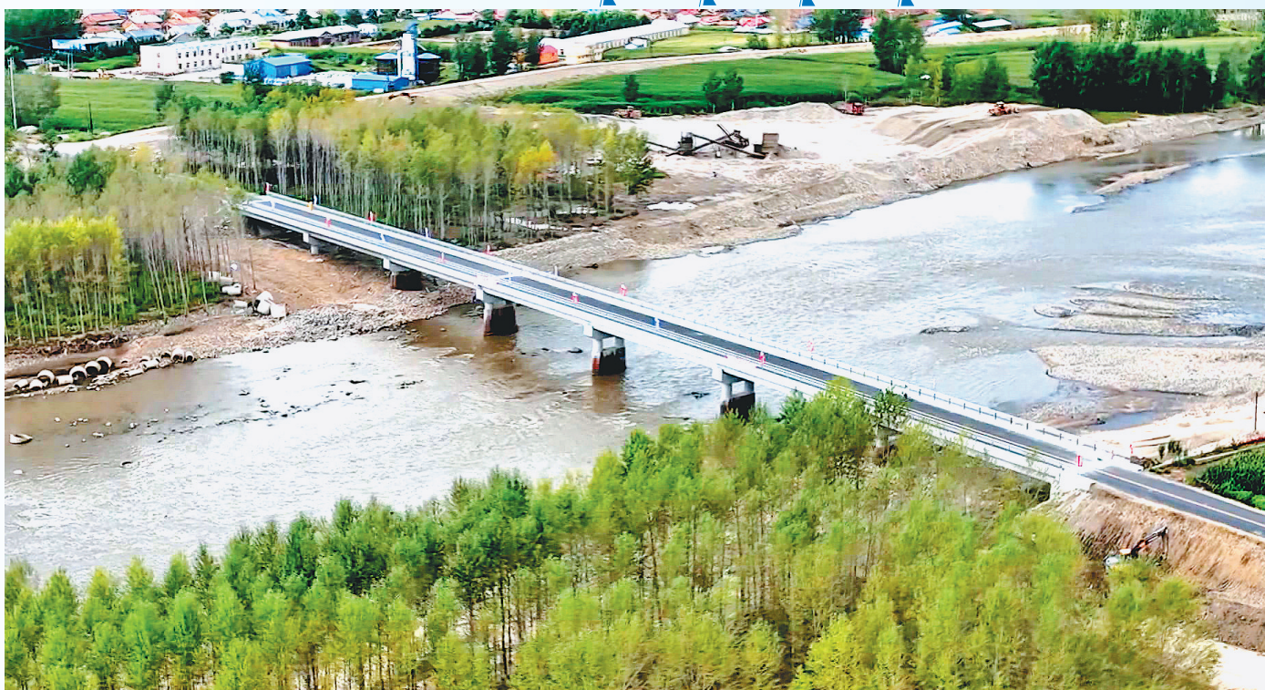
竣工通车的山咀子大桥。 图片由海林市融媒体中心提供
