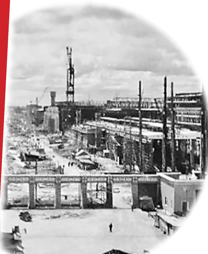
五十年代建设中的重型机器厂。
