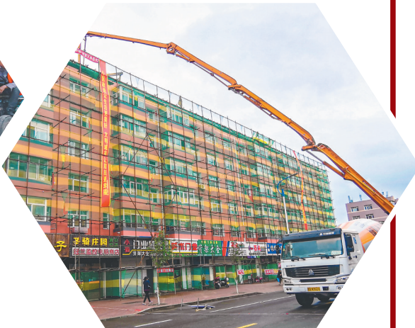
旧楼改造工程。
