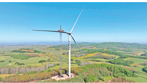
风机叶片正在吊装。本报记者 孙伟民摄
