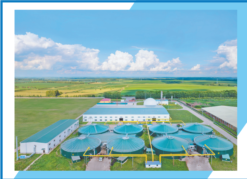
飞鹤生态循环综合利用项目。
