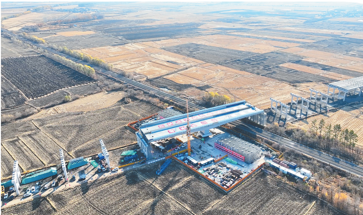
铁科高速公路铁风段跨绥佳铁路立交桥成功转体对接。
