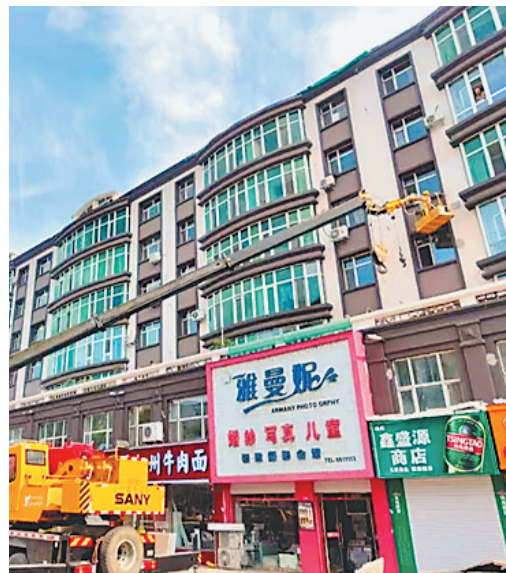
老旧小区改造工程进入收尾阶段。
