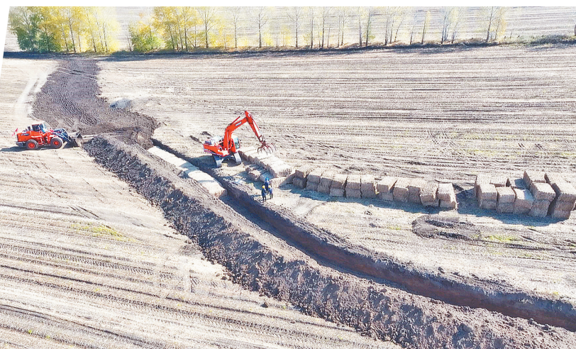
利用秸秆治理侵蚀沟。
