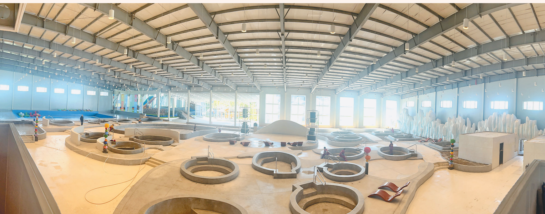
鹤鸣湖景区施工现场。
