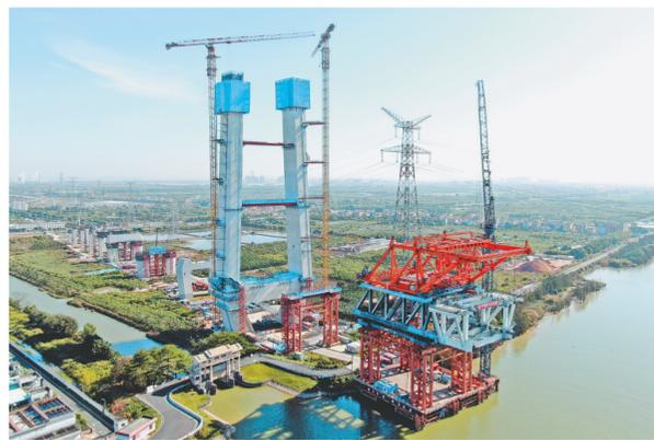
11月30日拍摄的深江高铁洪湾水道公铁大桥首节段钢梁架设现场。当日,由中铁大桥局承建的深江高铁洪湾水道公铁大桥首节段钢梁架设顺利完成,主桥上部结构正式进入钢梁拼装阶段。这也是深江高铁全线架设的首节段钢梁。新华社发
