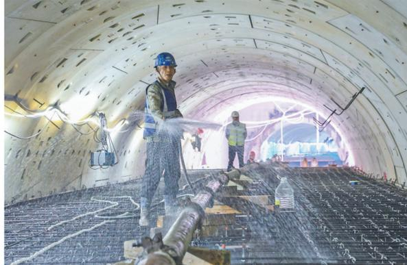
12月23日,中铁二十局施工人员在深圳地铁16号线共建管廊内向分仓中板钢筋浇筑水加温。
