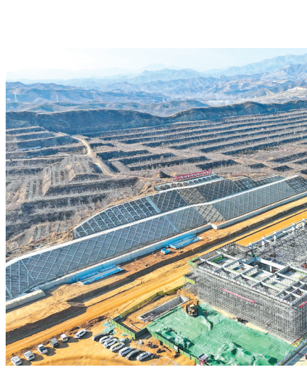
12月25日拍摄的雄忻高铁阜平站。
