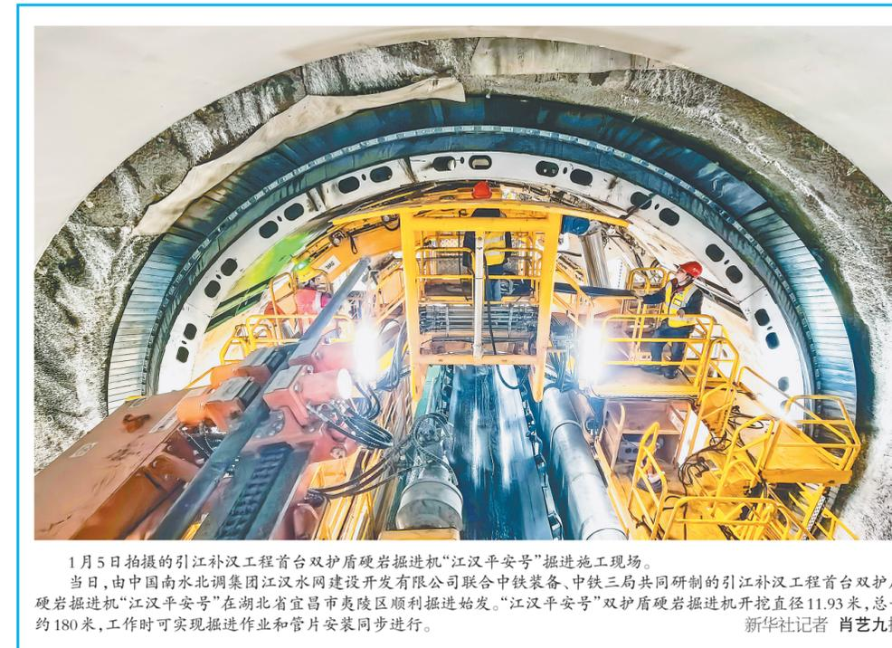
1月5日拍摄的引江补汉工程首台双护盾硬岩掘进机“江汉平安号”掘进施工现场。当日,由中国南水北调集团汉江水网建设开发有限公司联合中铁装备、中铁三局共同研制的引江补汉工程首台双护盾硬岩掘进机“江汉平安号”在湖北省宜昌市夷陵区顺利掘进始发。“江汉平安号”双护盾硬岩掘进机开挖直径11.93米,总长约180米,工作时可实现掘进作业和管片安装同步进行。
