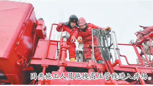
固井施工人员抱拽高压管线进入井场。
