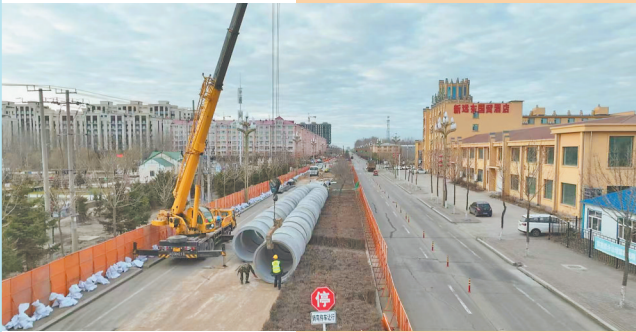
同江市雨水管道建设项目现场。
