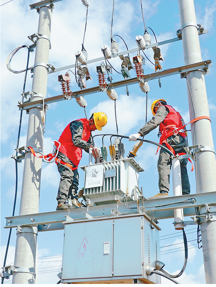
工作人员检查并清扫10千伏变压器。
