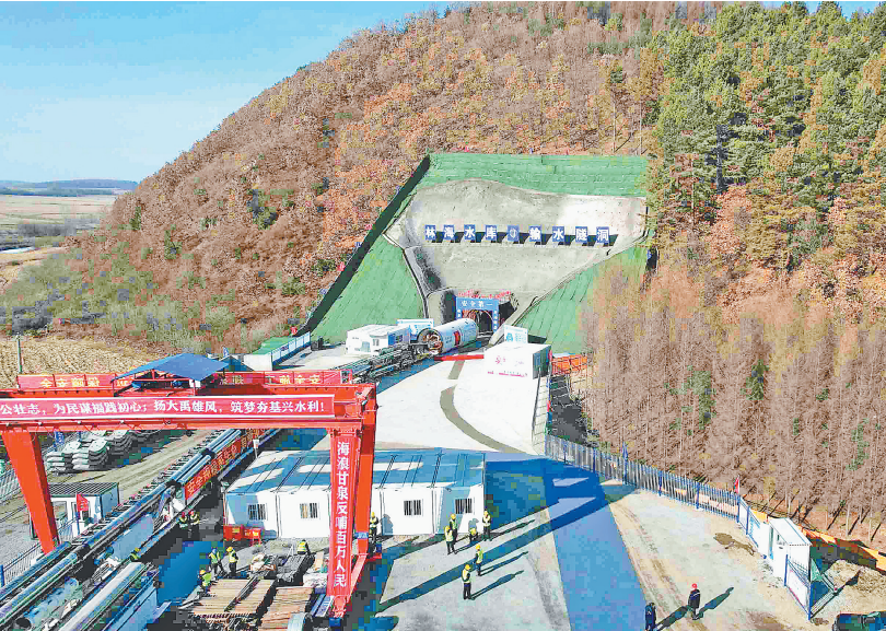
林海水库输水工程一期一号隧洞施工现场,“大禹号”TBM双护盾硬岩掘进机即将开工。
