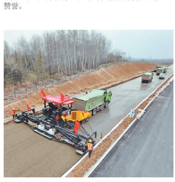
28日,随着水稳运输车、水稳摊铺机、压路机、洒水车等多个机械设备同时作业,铁科高速公路延寿尚志界段路面施工进入水稳摊铺阶段,为下一步转入沥青摊铺奠定坚实基础。
