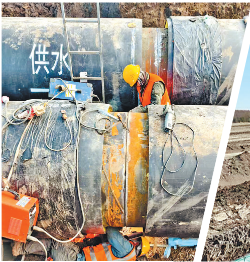
焊接供热管线。
