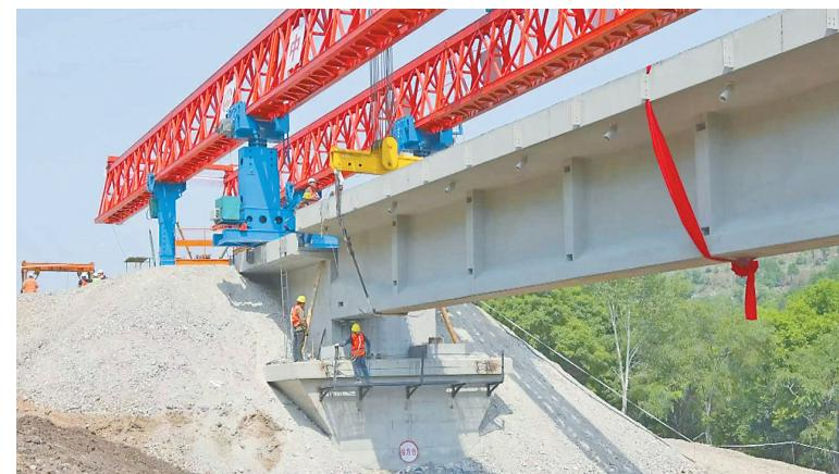
本报讯(赵海鹏 曲艺伟 记者杜怀宇)近日,在滨绥铁路绥芬河至国境线提质改造工程现场,随着一片长32米、重184吨的预制T型套轨精准地落在绥芬河1号桥桥墩上,标志着该工程首片梁成功架设,将为后续线路铺设奠定坚实基础。
