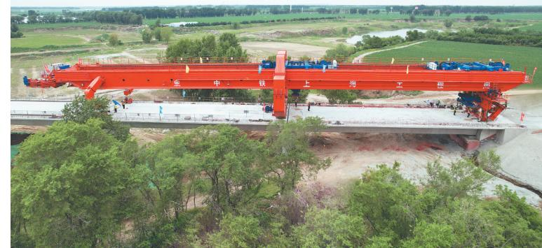
本报15日讯(郭懿 刘绪军 记者 王迪)15日,随着一榀714.8吨的预制箱梁精准架设在永兴呼兰河特大桥尾墩,哈伊高铁(哈尔滨至铁力段)永兴呼兰河特大桥箱梁架设全部完成,比计划工期提前一个月,为后续铺轨奠定了坚实基础。
