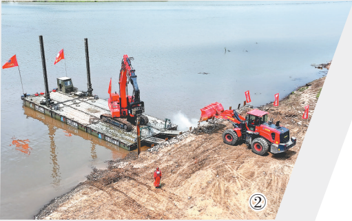
图①:使用智能无人挖掘机处置滑坡体。 图②:使用打桩船等装备抢筑临时码头。 图③:一架直升机运用一机四绳快速滑降新战法投送灭火队员。 图④:地面队伍压制模拟火线火势。 图①②张莉摄 图③④新华社发
