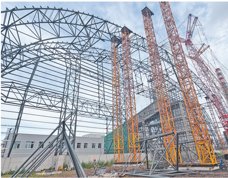
钢结构拼装施工。
