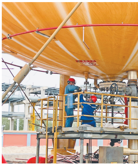
工人正在进行球罐检定。
