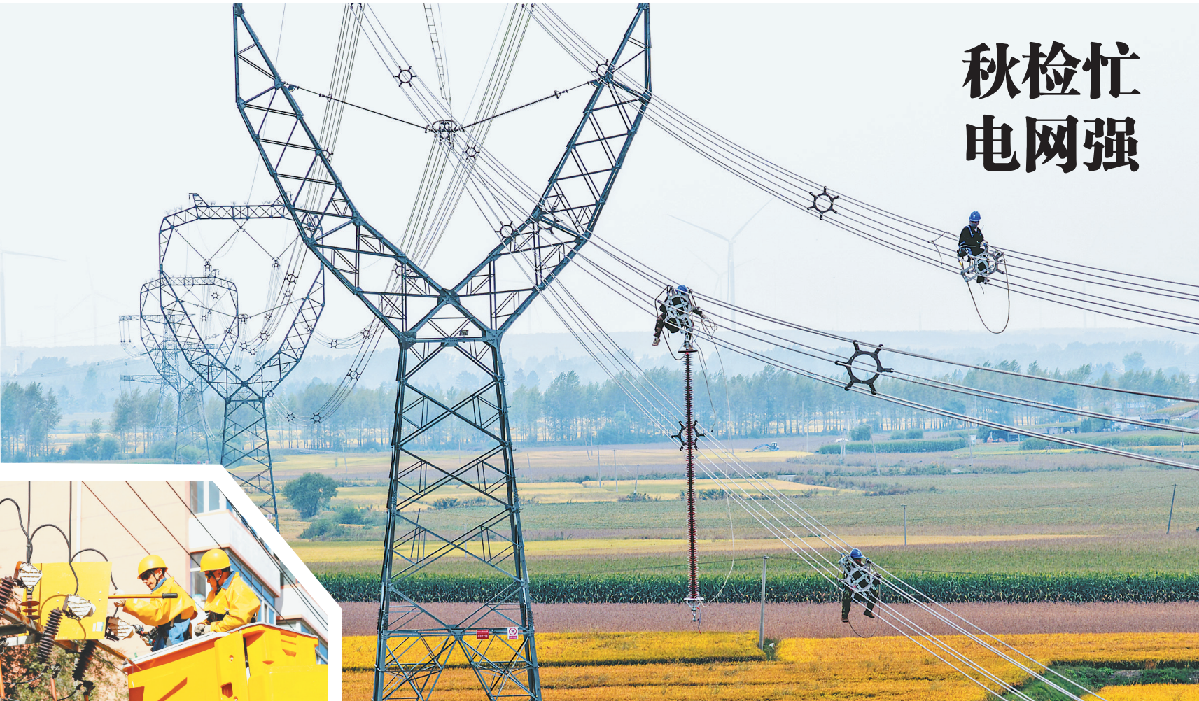
带电作业人员正安装新型快速跌落开关。
