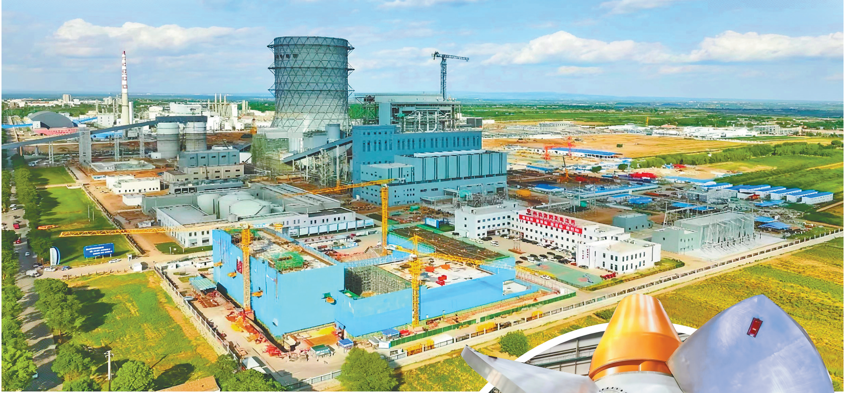
哈电集团研制的 world 首台参数最高、单机容量最大陕西彬长660兆瓦高效超超临界循环流化(CFB)发电项目1号机组。
