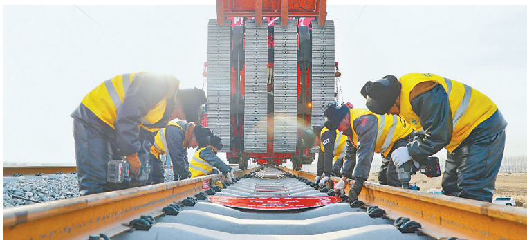
施工人员拧紧钢轨螺栓。马赫摄
